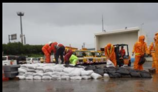
土のう敷設訓練状況
