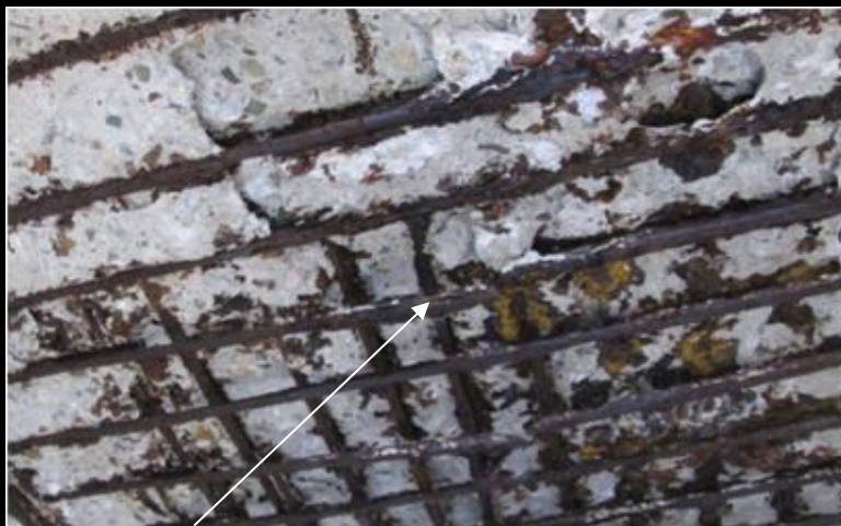
床版鉄筋の破断・腐食及びひび割れの進行
