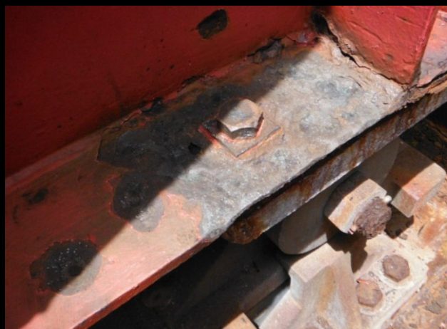
ケレン後の状況
