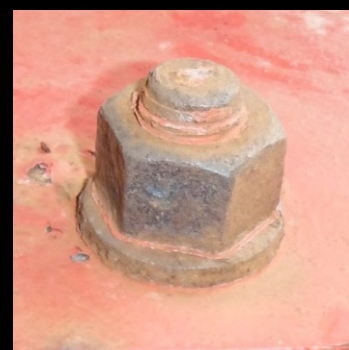
ケレン後の状況
