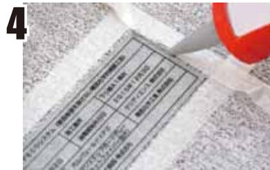
外側に2~3ミリの隙間をあけてマスキングテープで養生してください。そして汎用シリコンシーラントで周囲を目留めします。
