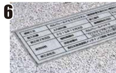
マスキングテープを剥がせば施工完了です。完全に硬化するまで触れないで下さい。
