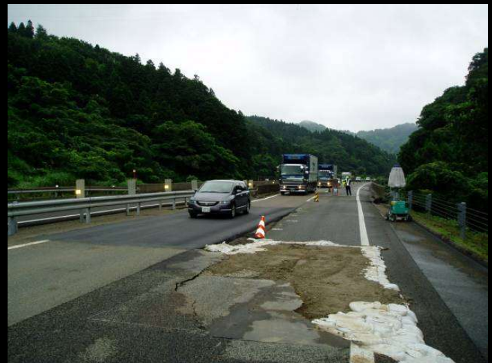
土のうによる道路啓開
