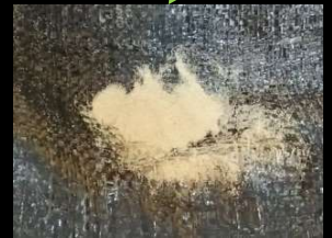
一般土のう④破断状況
