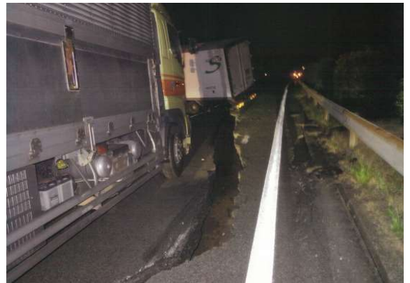
段差・亀裂の緊急復旧資材として活用 (写真：熊本地震)
