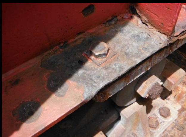
ケレン後の状況
