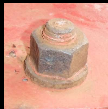
ケレン後の状況
