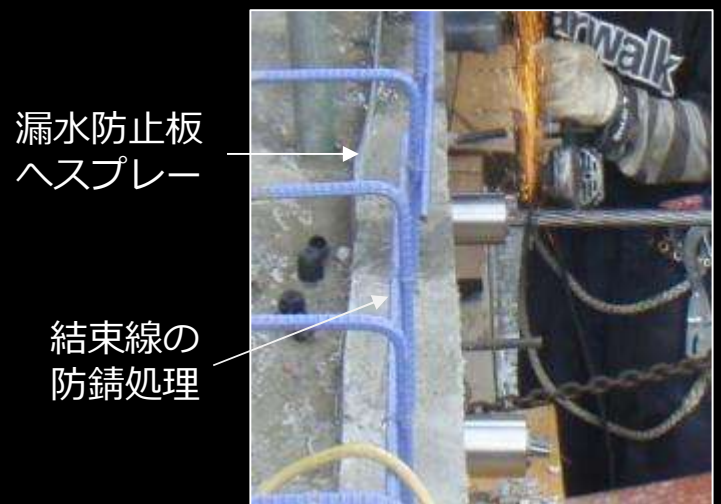
コンクリート打設前の塗布が特に有効です。
